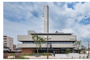
松江放送会館(2023年完成)
