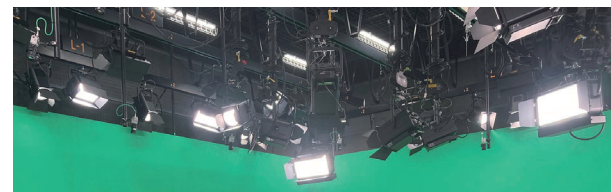
地域放送局制作スタジオのLED照明器具導入
