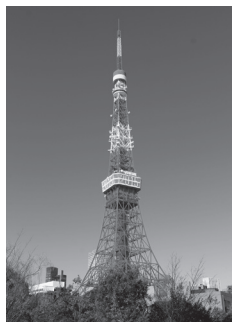
東京鐵塔(333公尺)
