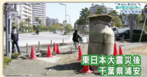
周りが下がっている 結局的には浮き上がり
