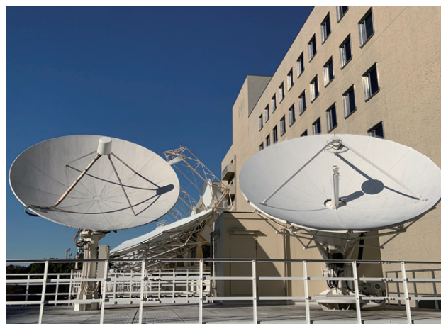
衛星回線送受信アンテナ
