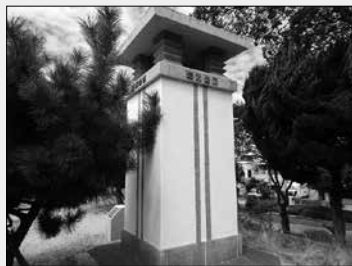
図2 兵庫県明石市中崎遊園地のラジオ塔 (2017年8月31日筆者撮影)
