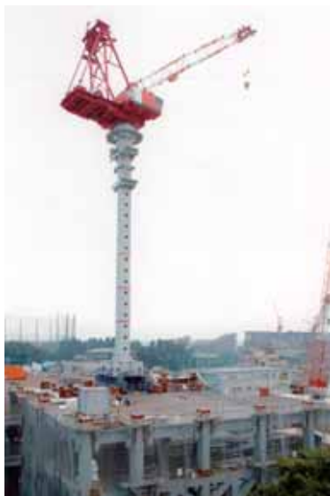
タワークレーン取り付け（2000年7月）
