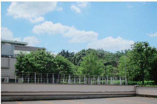
▲ 放送センターの屋上緑化
