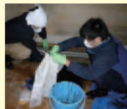
狭い穴に潜り込んで、津波により堆積した泥(ヘドロ)をかき出す
