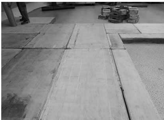
敷き詰められた「平台」。この上にセットを建てる
