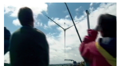
デンマーク 地域で風力発電所を建設
